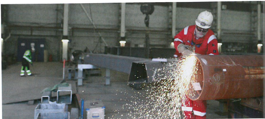
Satsinga på stålarbeid har bore gode frukter, og Halsnøy Verft har dei siste åra gjort mykje bra arbeid på dette feltet. Jobbane for Apply gjer at dei no er sertifiserte for å utføre oppdrag både for Statoil og Kværner.
